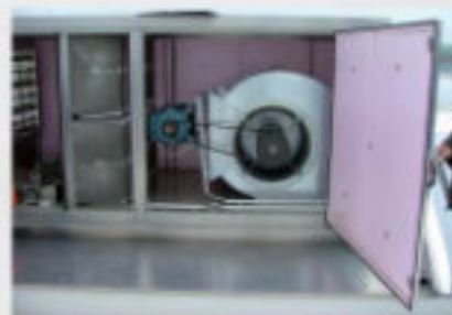
Moduł wentylatora z radialnym wiatrakiem
