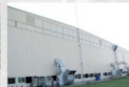
AIRJET zamontowany w ścianie
