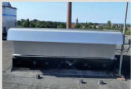
Zamontowany na ukośnym cokole
