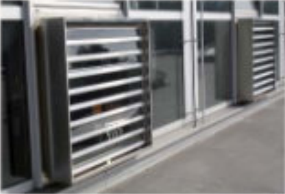
SMOKEJET zamontowany pionowo
